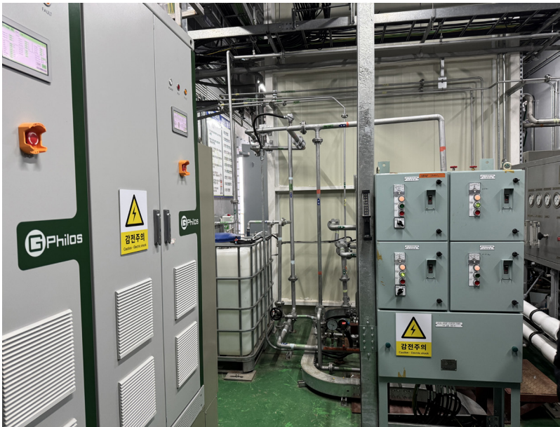
고정식 해양그린수소 생산 실증시스템 운송, 전력변환설비, 해수담수·냉각설비 현장설치
