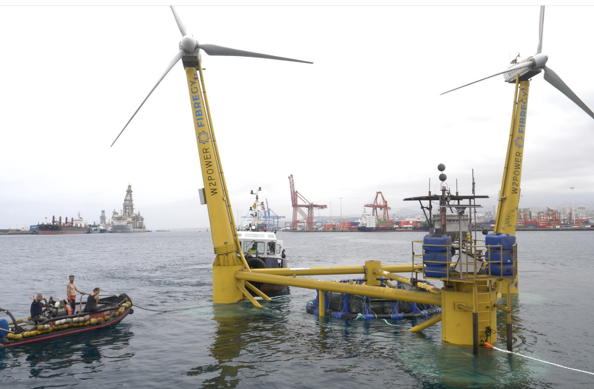
라스팔마스 데 그란 카나리아 대학교(ULPGC)에서 개발한 최첨단 양식 케이지와 부유식 이중 터빈 해상풍력터빈(W2Power)이 통합된 다목적 해상 플랫폼
